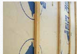
外壁材を剥がした直後の壁パネル。20年経ってもほとんど経年劣化は見られません。
